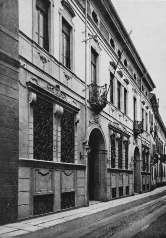
Sede della Camera di Commercio al n. 18 di via Beltrami (1911-1941)
