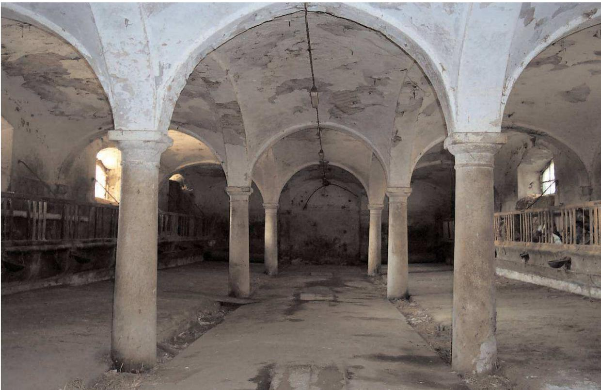
Stalla della vacche da latte a doppia posta con corsia centrale e soffitto a volte sostenuto da colonne
